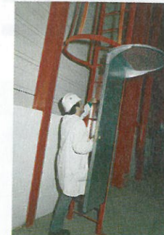
Système à fermeture automatique et déverrouillage d'urgence en issue de secours
